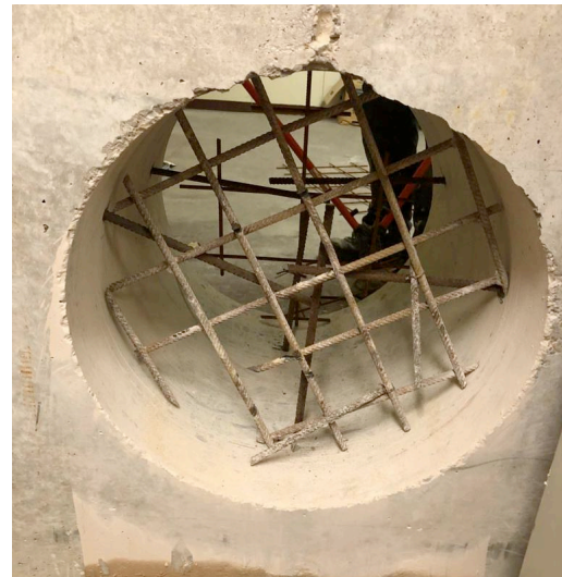
Mannloch einer Kernbohrung
